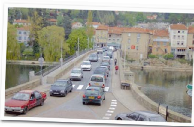
Le pont de Brives... un véritable problème.
