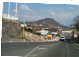
Les travaux du Pont de Bellevue réalisés par l'agglo du Puy en Velay
