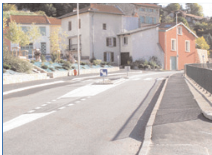
Rue des Moulins : Accès Place de l'Ormeau
